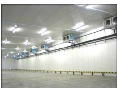
> Электромонтажные работы, пусконаладочные работы системы эл. обогрева полов камер глубокой заморозки.
